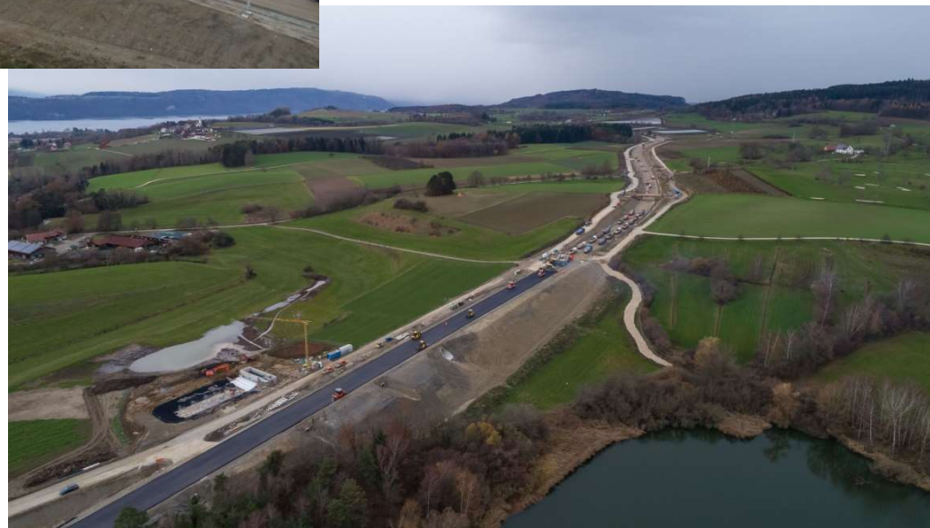
Asphalteinbau zw. Bauanfang (Tierheimknoten) und L 195
