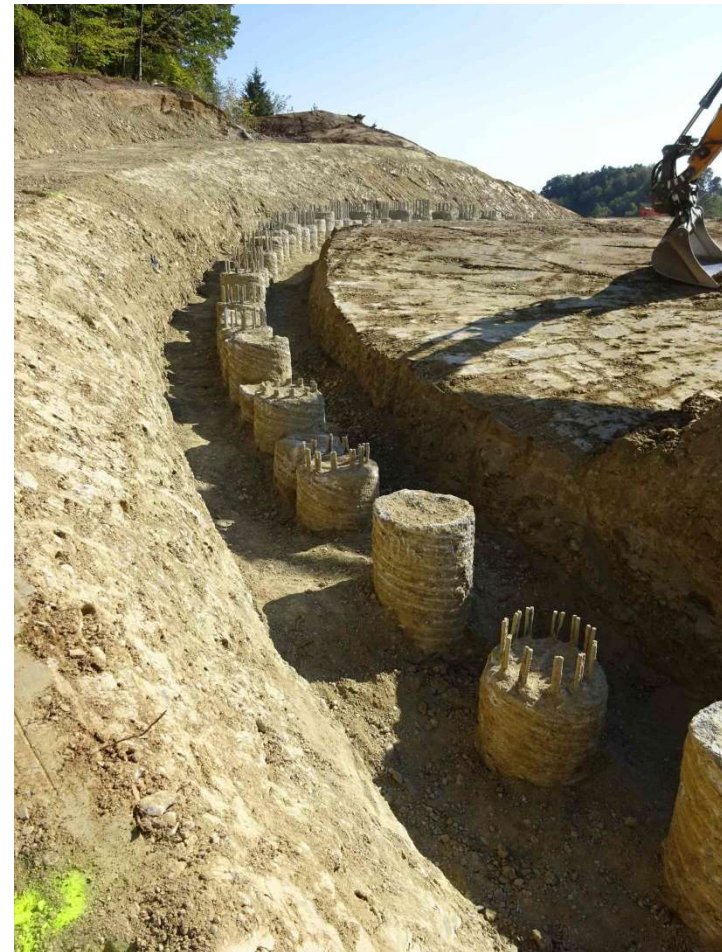
Aufgelöste Bohrpfehlwand
