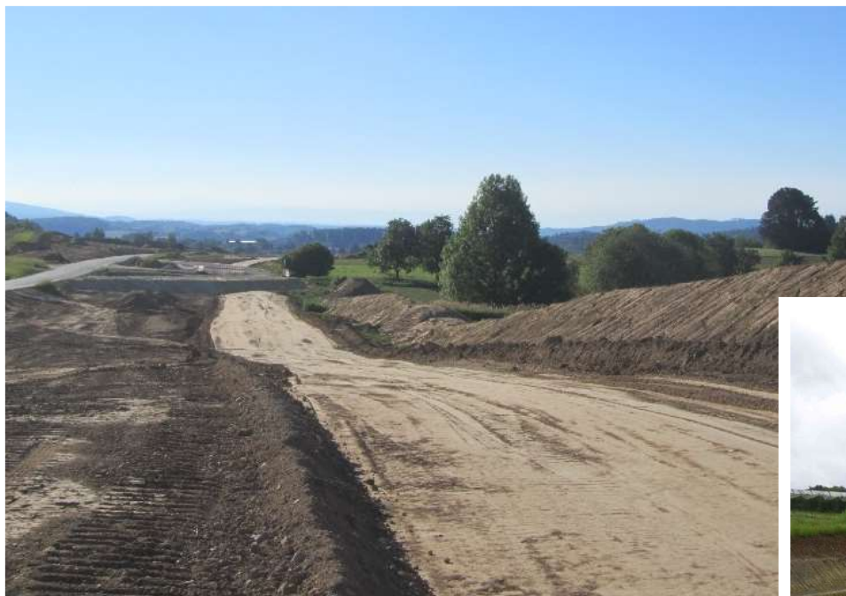
Erdbau zw. Ausbauende und L 195
