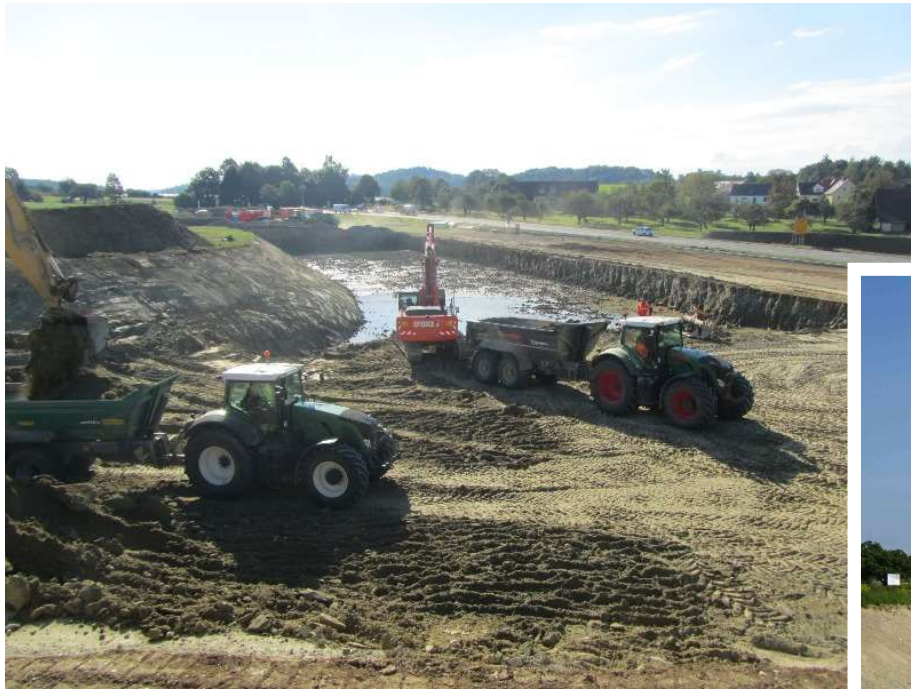
Voreinschnitt für Brückenbauwerk BW 2
