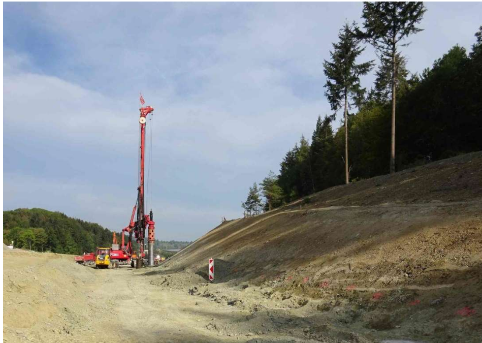
Herstellung von Bohrpfehlen für Stützwände
