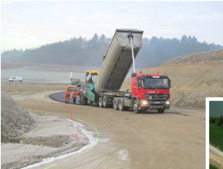
Asphalteinbau
