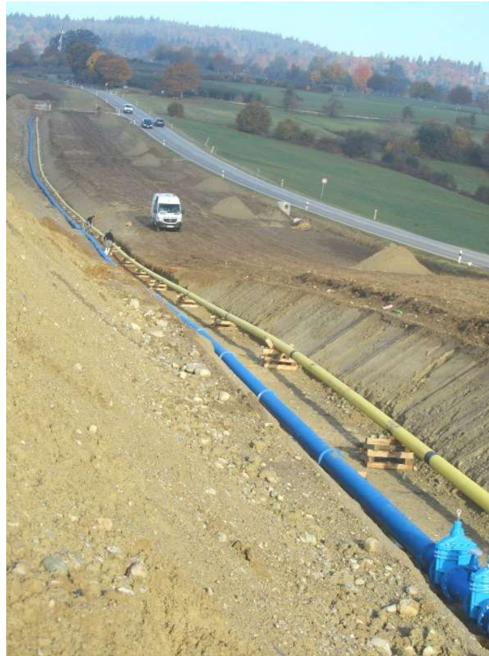
Leitungsverlegungen entlang der Trasse B 31 neu
