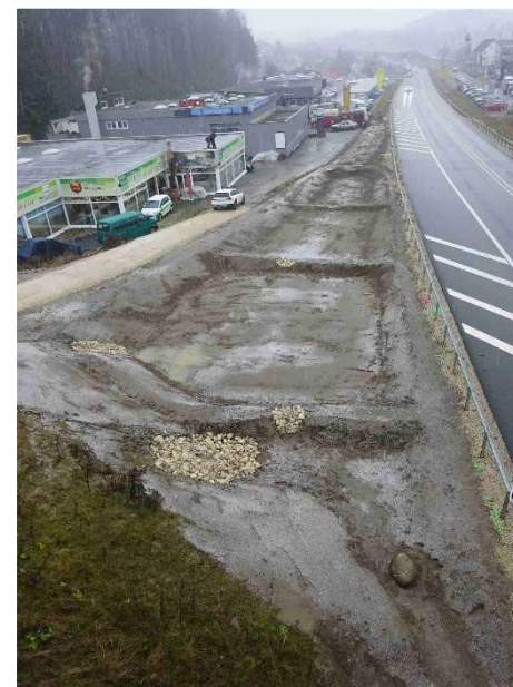
Herstellung Regenfilterbecken
